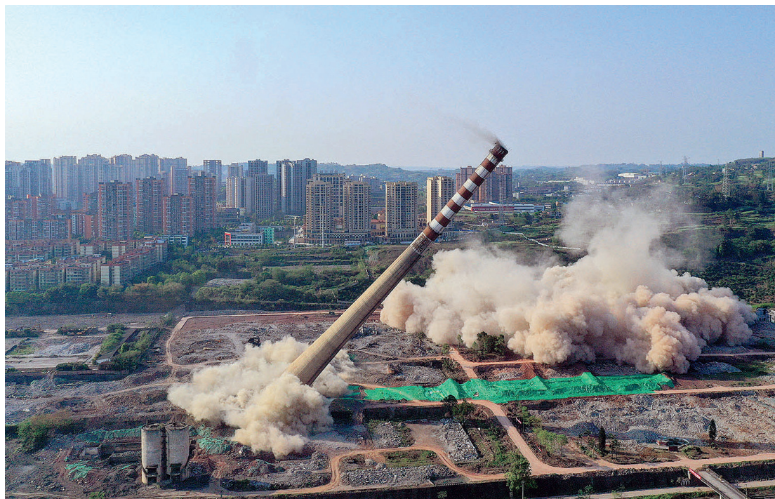
发电厂拆除。供图 / 宜宾市生态环境局
