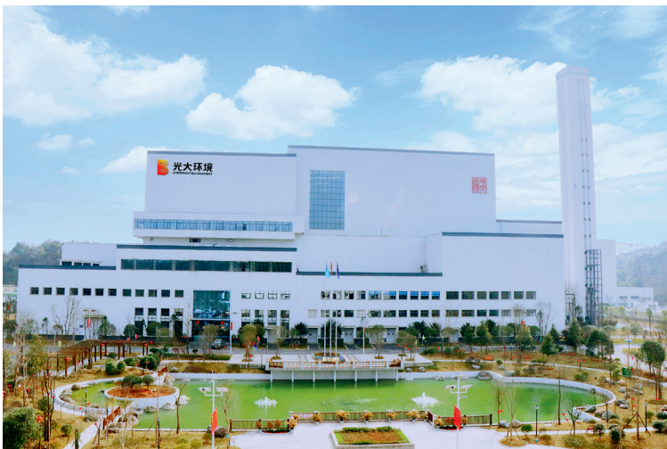
垃圾发电厂全景。供图 / 乐山市生态环境局
